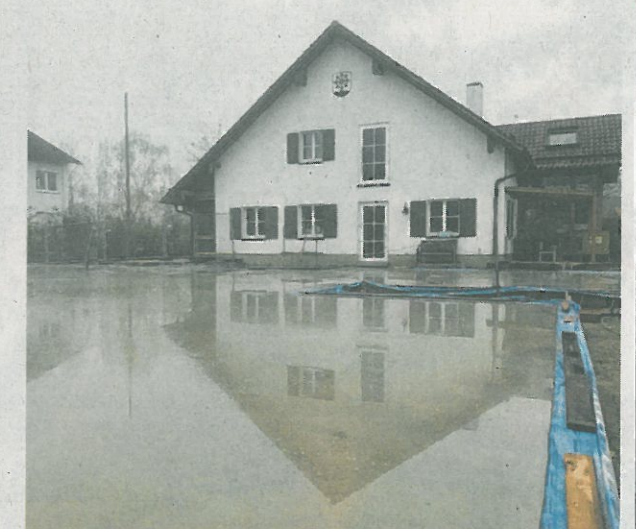
Vergangenen Donnerstag wurde die Bodenplatte für den Erweiterungsbau betoniert. Foto: Architekt Stefan Mohr
