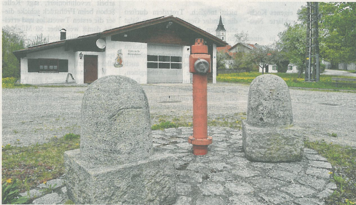
Für das Feuerwehrhaus in Thaining sind zu viele Schlüssel im Umlauf. Der Gemeinderat hat deswegen jetzt beschlossen, eine neue Schließanlage einbauen zu lassen.
